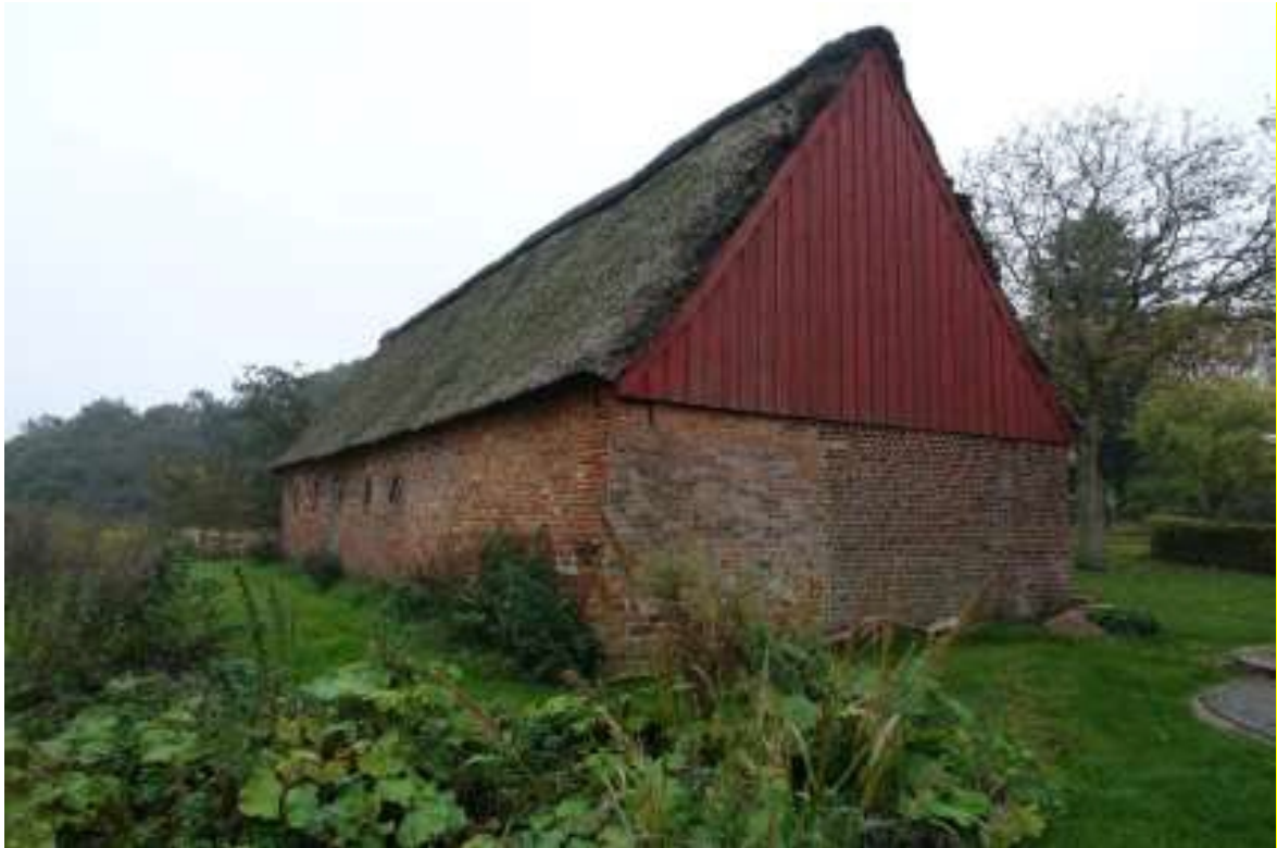
Starup Hedevej 21, Facade mod vest / fjorden
