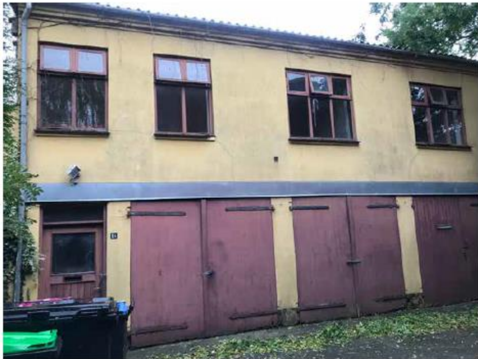
facade af baghus
