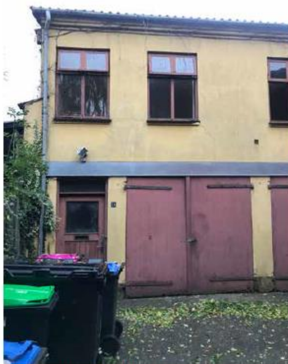
facade af baghus
