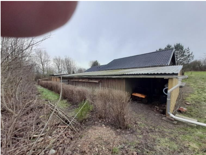
Fra ansøgningen: Bygn. 2 Træpilleskur og carport fra øst
